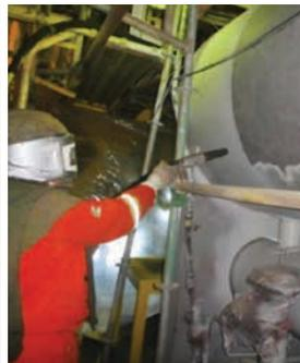
Staubarme Strahltechnologie mit Sponge-Jet
