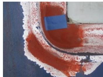
Vor der Beschichtung mit dem Elastomer wurde ein Klebeband über die Risse gelegt, um einen Bereich ohne Adhäsion zu bilden, in dem sich die Beschichtung dehnen kann und dennoch intakt bleibt.
