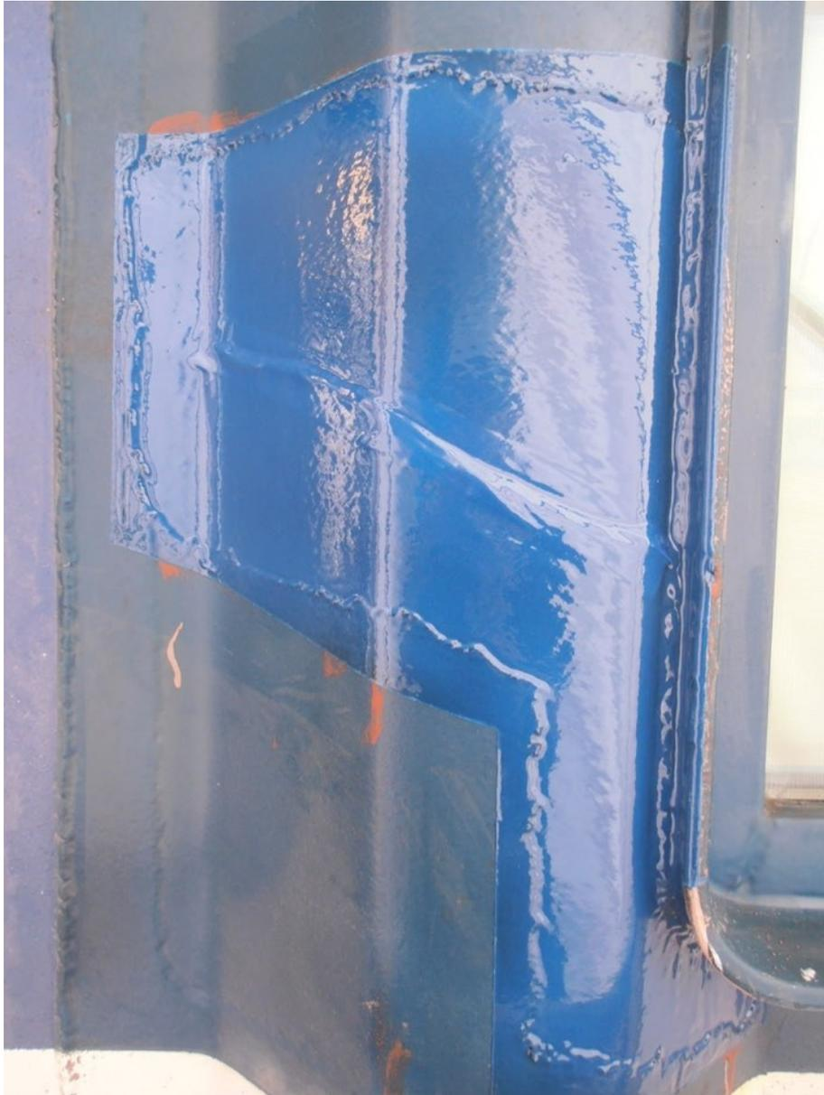
Der Riss in der Stahlplattierung sowie der Riss in der Schweißnaht entlang des Fensterrahmens wurden mit Elastomer beschichtet. Sollte der Riss trotz der Schweißung aufbrechen, sorgt die Elastomerbeschichtung dafür, dass keine Leckage entsteht.
